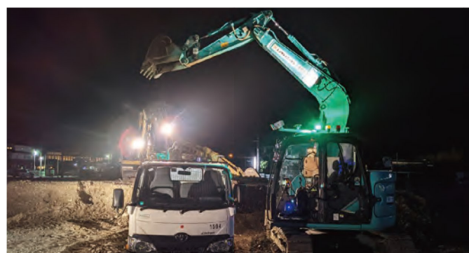
画像1：実証実験では無人のショベルカーとトラックが自動運転での掘削を実現
