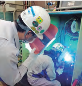
シェア元の動き (ベテラン溶接工)
