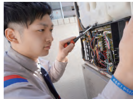
給湯器修理の様子
