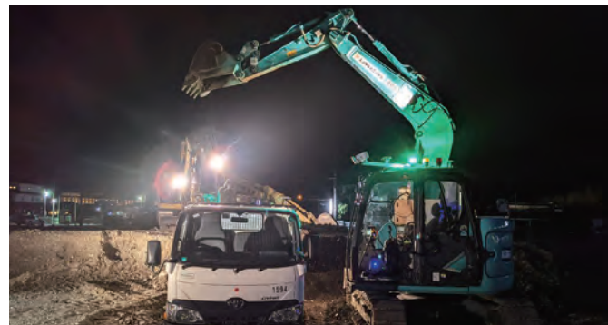
画像1：実証実験では無人のショベルカーとトラックが自動運転での掘削を実現
